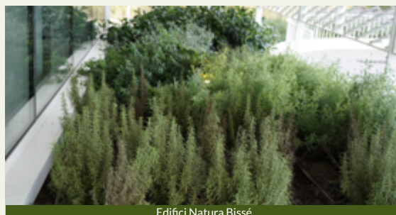
Edifici Natura Bissé
