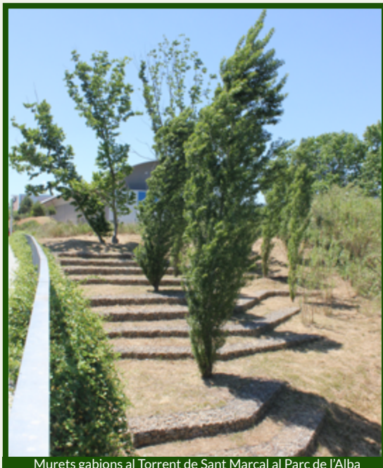
Murets gabions al Torrent de Sant Marçal al Parc de l'Alba
