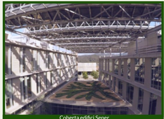
Coberta edifici Sener
