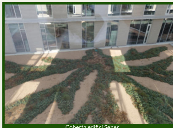
Coberta edifici Sener
