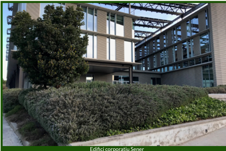
Edifici corporatiu Sener
