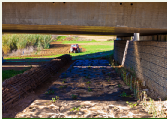
Refugis de fauna sota el viaducte de Cant Fatjó
