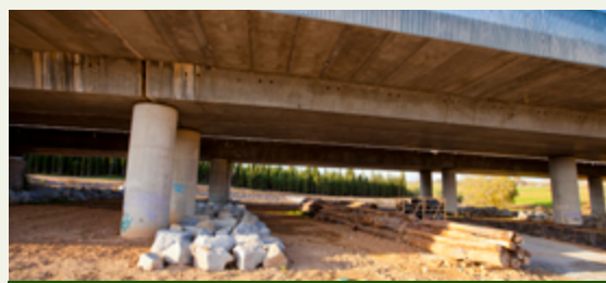
Refugis de fauna sota el viaducte de Cant Fatjó
