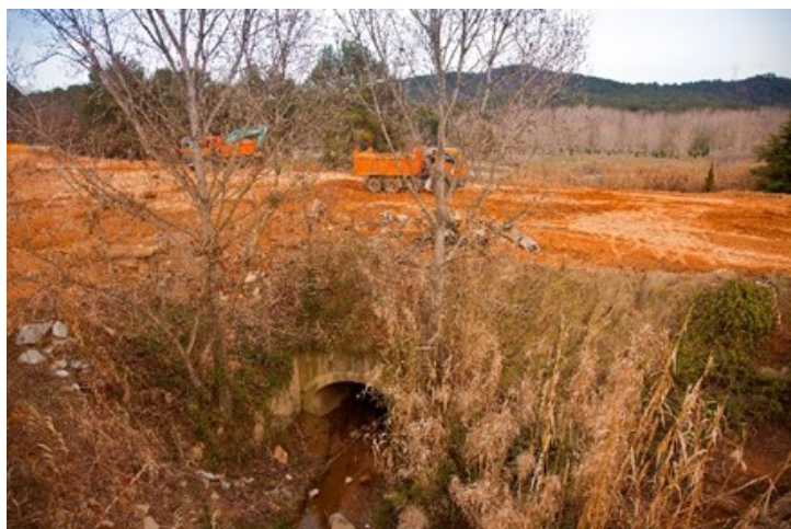
Antigues obres de drenatge existents en la carretera BP-1413 en sectors que han estat objecte de desfragmentació. A l'esquerra al Torrent de Can Fatjó i a la dreta al Torrent del Bosc, ambdós torrents són eixos estructuradors del corredor verd.
