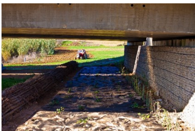
Detalls de les adaptacions realitzades al viaducte del Torrent de Can Fatjó per afavorir el pas de la fauna i que integren refugis per a petita fauna com ara insectes, invertebrats o micromamífers.
