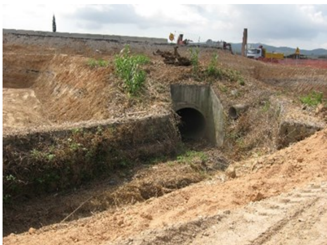
Antigues obres de drenatge existents en la carretera BP-1413 en sectors que han estat objecte de desfragmentació. A l'esquerra al Torrent de Can Fatjó i a la dreta al Torrent del Bosc, ambdós torrents són eixos estructuradors del corredor verd.
