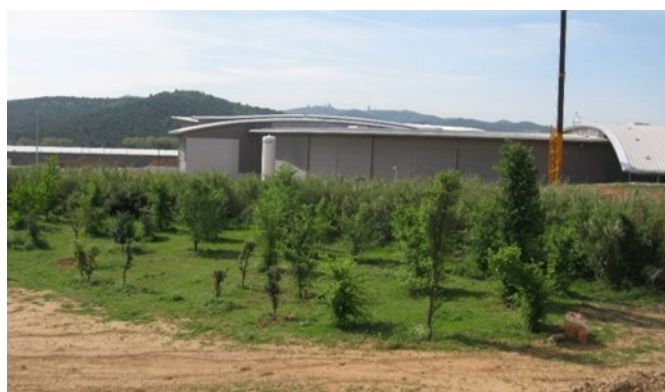
Reforçament del bosc de ribera en el parc urbà del torrent de Sant Marçal. Al fons l'edifici del Sincrotró, en construcció. Els arbres es van aprofitar de masses forestals afectades per les obres d'urbanització.
