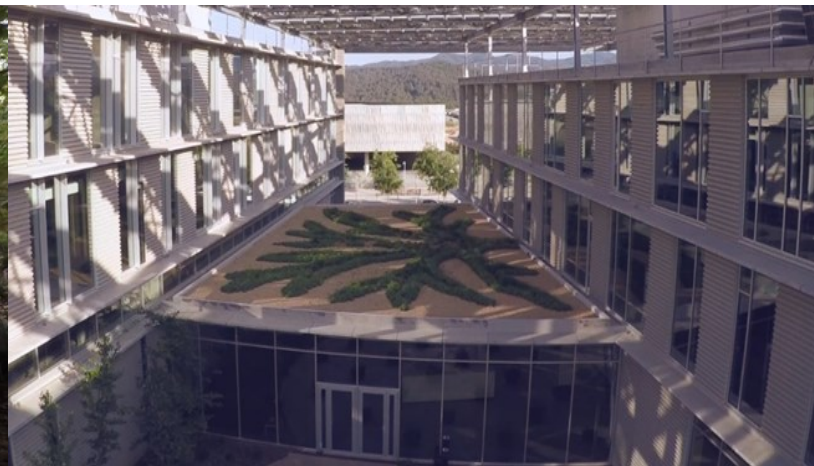
Sostre verd a l'edifici corporatiu de SENER al Parc de l'Alba.
