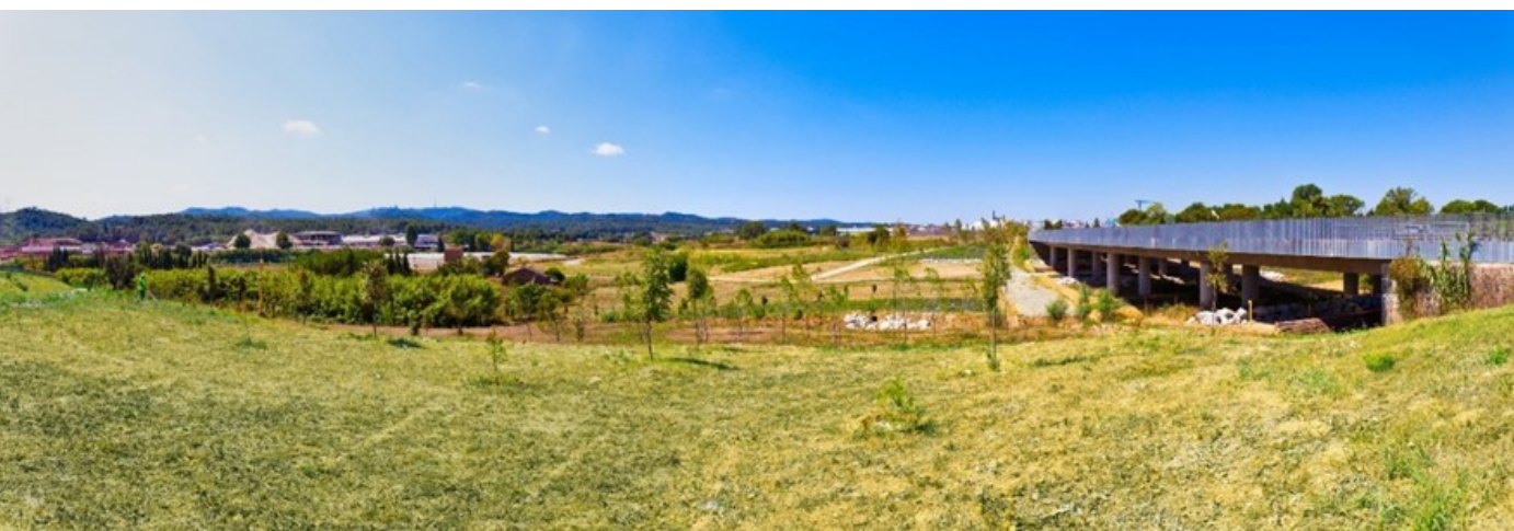
Perspectiva del corredor verd des d'on s'aprecien les zones restaurades i el nou viaducte del Torrent de Can Fatjó, una estructura de connectivitat que ha permès desfragmentar els hàbitats.
